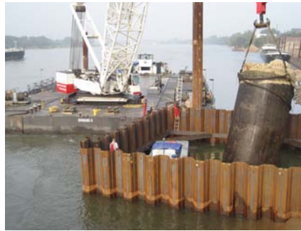
Bilder 11a bis 11c: Umlenkung, Ausheben, hängender Abschnitt
