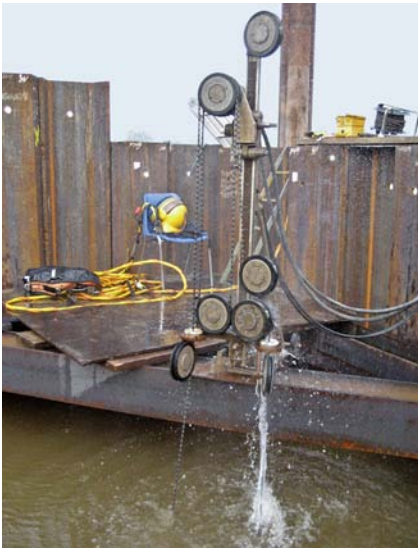
Bilder 11a bis 11c: Umlenkung, Ausheben, hängender Abschnitt
