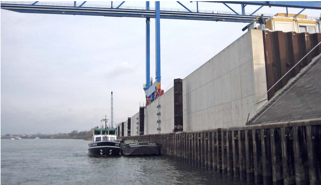
Bild 1: Fertige Uferwand mit Portalkran
