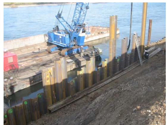
Bild 14: Rammarbeiten Böschung
