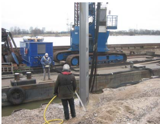
Bild 18: Tiefenverdichtung
