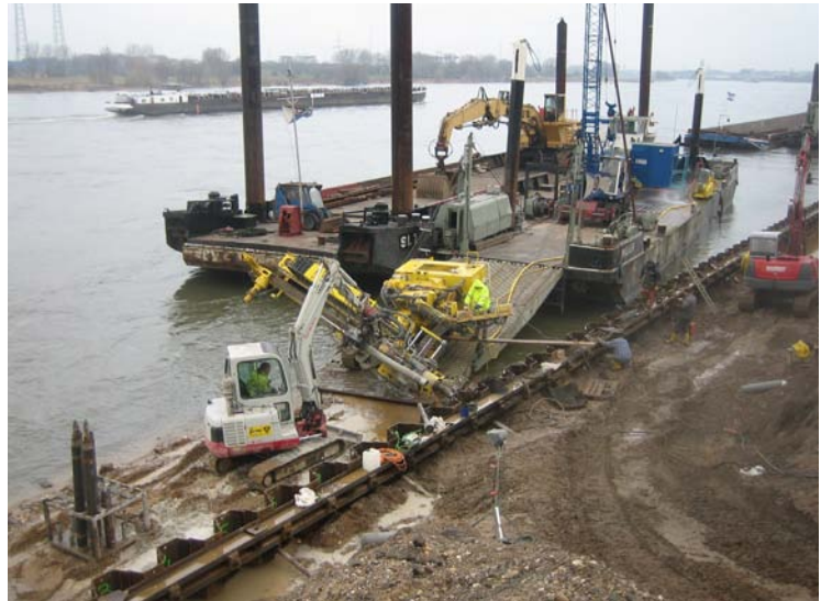
Bild 21: Ankerarbeiten vom Ponton
