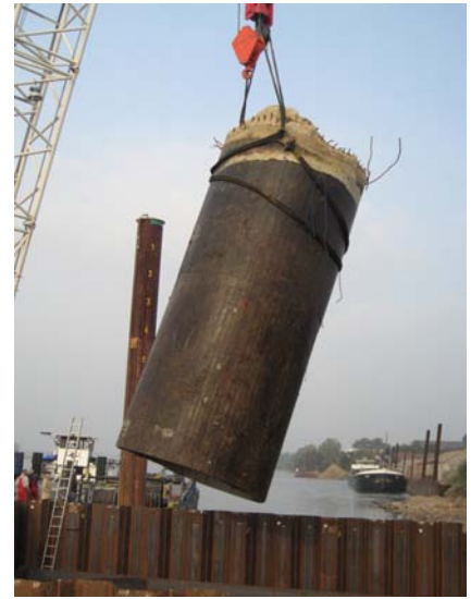
Bilder 11a bis 11c: Umlenkung, Ausheben, hängender Abschnitt
