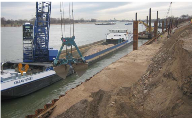
Bilder 17a und 17b: Hinterfüllung sowie Ansicht mit Anker
