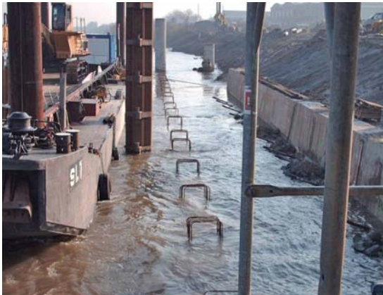
Bild 24: Hochwasser mit Bohrpfahlbewehrung
