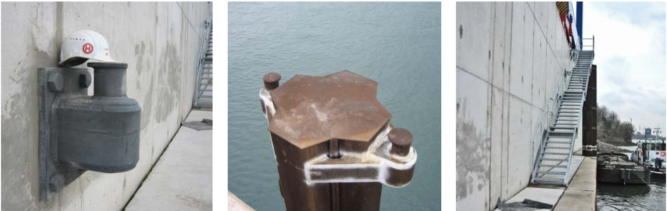
Bilder 27a bis 27c: Geprüfte Poller und Treppenanlage
