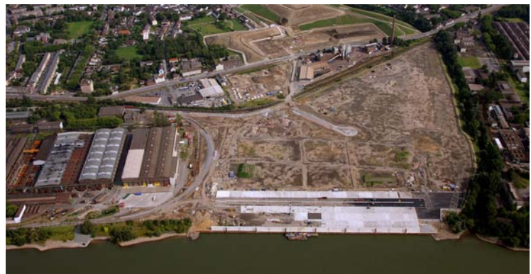
Bild 3: Luftbild mit Uferwand, Schiene, Strasse
